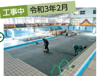
プール床面と壁面、プールサイドのタイル貼り。
