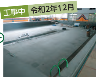
プール槽内の防水シートとプールサイドのスタート台を撤去。
