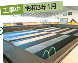
プール槽内の防水層を削り取り補修。排水溝と背泳ぎスタート用のグリップボックスを塗装。
